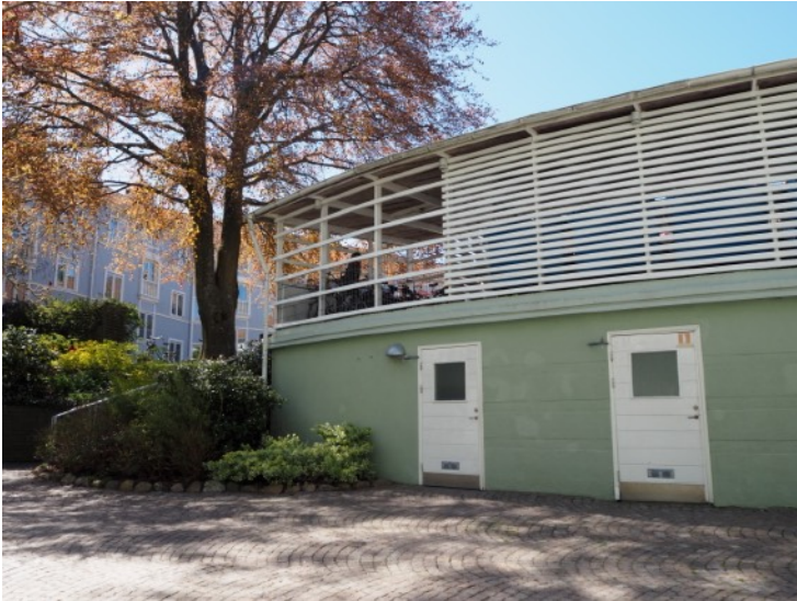
Figur 11: Soprummet i sutteräng med påbyggnad och de nya dörrarna som ersätter de tidigare fönstren.
