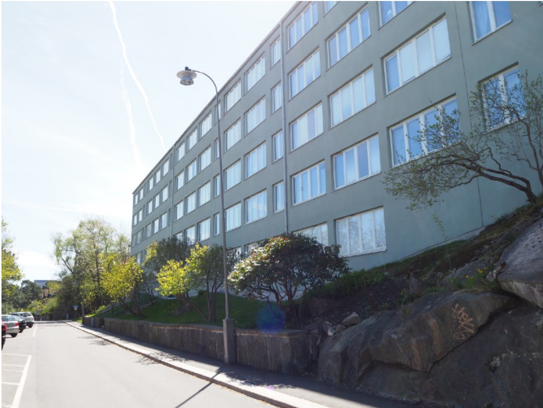
Figur 7: Kolonigatan 9, fasad mot gatan med fönsterband, osynligt tak och ljusgrön infärgad fasad. Den sluttande förträdgården med uppstickande bergsknallar syns i förgrunden.
