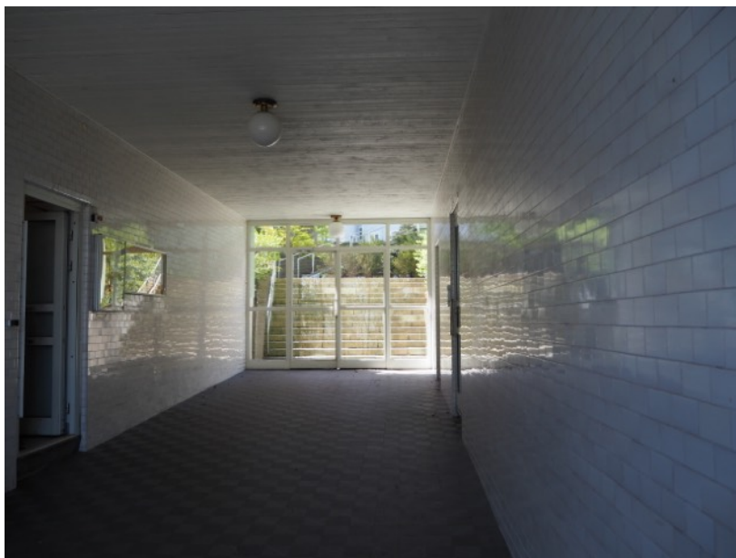
Figur 13: Passagen under Kolonigatan 9 mot innergården. Väggarna är kaklade och på golvet ligger ett klinkergolv med struktur. Entrépartiet mot innergården är likadant som det mot gatan.
